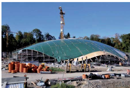
Kernstück der neuen Elefantenanlage im Zürcher Zoo ist das in den Park eingebettete Elefantenhaus mit einer 6000 Quadratmeter grossen, stützenfreien Halle.
