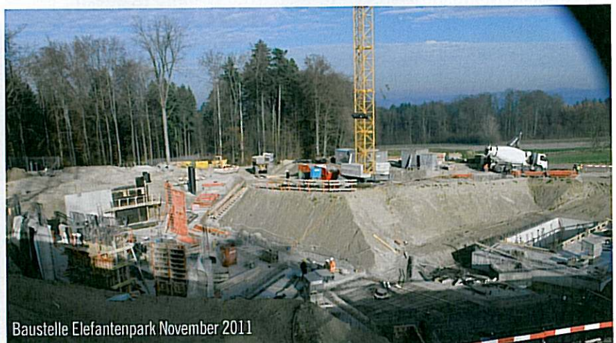
Baustelle Elefantenpark Mai 2011
